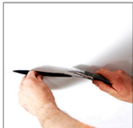
**10** Для фиксации пленки на углах сделайте разрез пленки по биссектрисе угла, отступив от профиля 3мм. Одновременно перегните обе стороны пленки и зафиксируйте на kleевую основу. Для дополнительной фиксации угла нанесите небольшую каплю клея монтажным крючком непосредственно на областьстыковки профиля на углу и при помощи монтажного крючка и монтажной лопатки прижмите материал к профилю. Это позволит сформировать четкий угол 90°.
