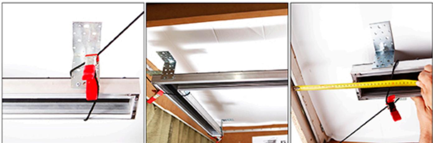
**4** Установите нишу на основном потолке согласно дизайн-проекта и уровню стекового профиля, заведённому по периметру помещения. При больших площадях рекомендуется производить монтаж на гибких консолях (перфопластина) во избежание искажения-линзирования плёнки после монтажа.
